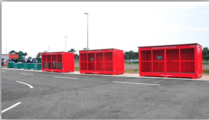
Slika 3. Primjer skladišta opasnog otpada u reciklažnom dvorištu
