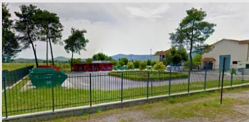
Slika 2. Primjer reciklažnog dvorišta u Podgorici
